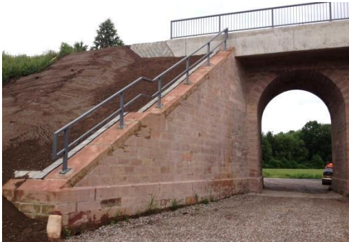
Bild 1: Ansicht Flügel und Kopfbalken [1]
