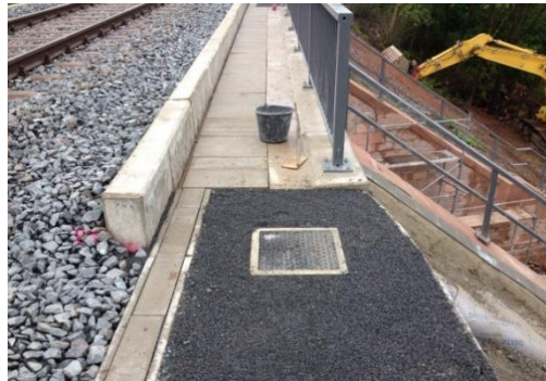
Bild 2: Ansicht Kappe und Randweg [1]
