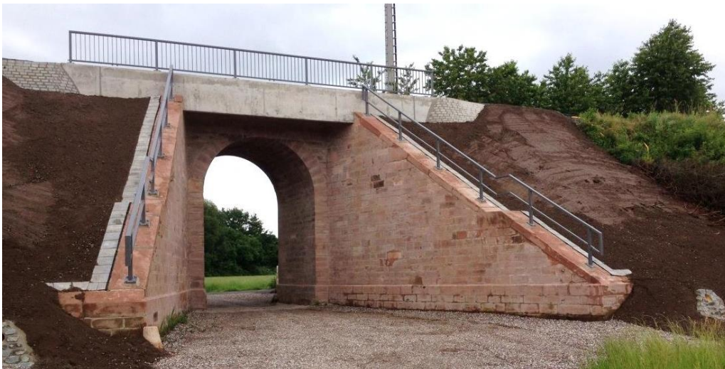
Bild 3: Bauwerk nach der Sanierung, Ansicht aus Richtung Süden [1]
