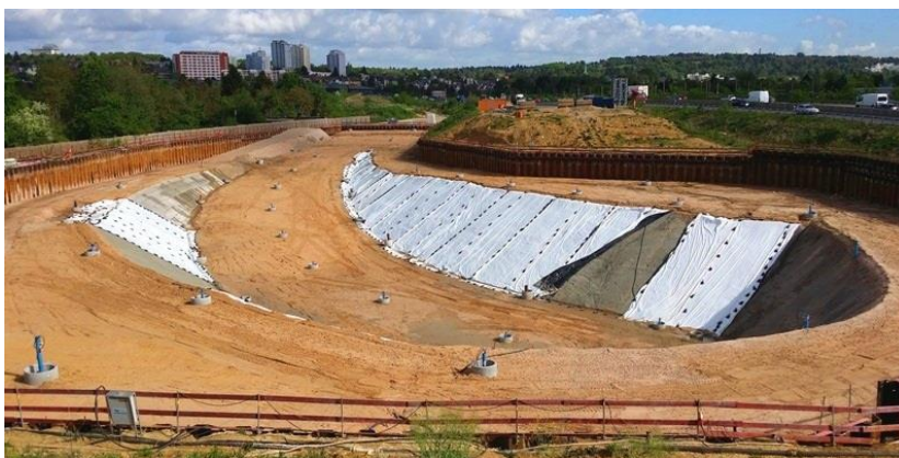
Bild 3: Fertige Baugrube und Zufahrtsrampe [1]
