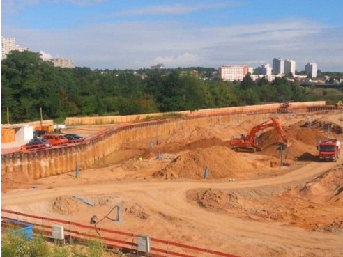
Bild 1: Baugrube mit Brunnen [1]
